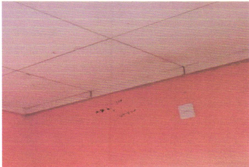
FOTO 03- TOMADA BAIXA DE EMBUTIR (1 MÓDULO), 2P+T 10 A, INCLUINDO SUPORTE E PLACA - FORNECIMENTO E INSTALAÇÃO. AF_12/2015
