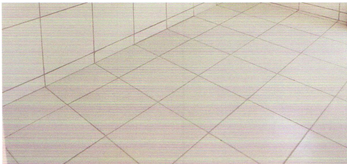
FOTO 06 - REVESTIMENTO CERÂMICO PARA PISO COM PLACAS TIPO ESMALTADA EXTRA DE DIMENSÕES 45X45 CM APLICADA EM AMBIENTES DE ÁREA ENTRE 5 M2 E 10 M2. AF_06/2014
